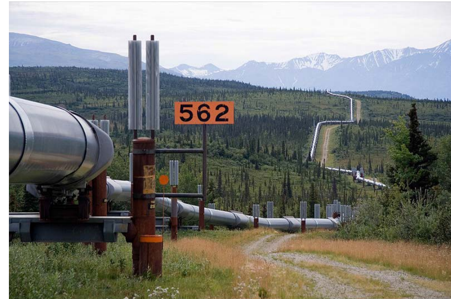
Fig. 12: Trans-Alaska pipeline (image: Luca Galuzzi)
